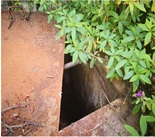
化验室废液沉淀池
