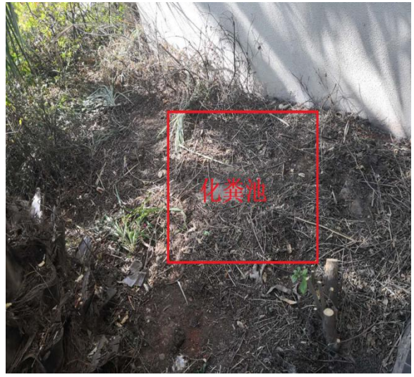
化验室化粪池
